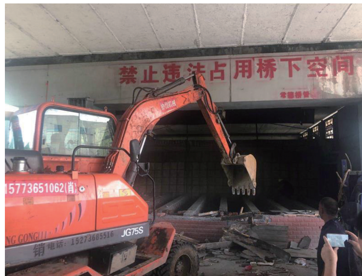
图为拆违现场。
