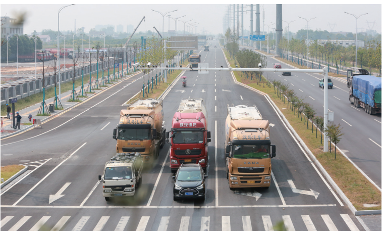
昨日上午,市城区柳叶大道附近丹溪路上,车辆正按照交通指示灯行驶。目前,丹溪路已正式通车。丹溪路起自沅水四桥北岸,止于太阳大道,沿线途经武陵区丹洲乡、芙蓉街道社区、河洑镇和鼎城区灌溪镇,全长13.144公里。李龙 摄
