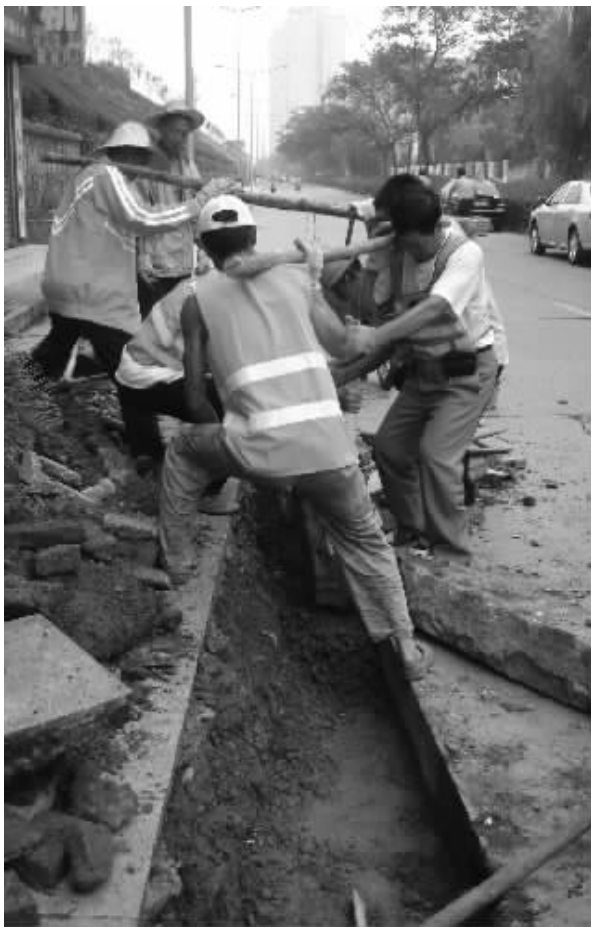
7月30日,市政工人正在对市城区沅安路破损的人行道板进行整修。此次大规模的整修涉及市城区人民路、武陵大道、朗州路等主干道上的近万平方米人行道板和车行道板,工程将于8月初全面完成。
