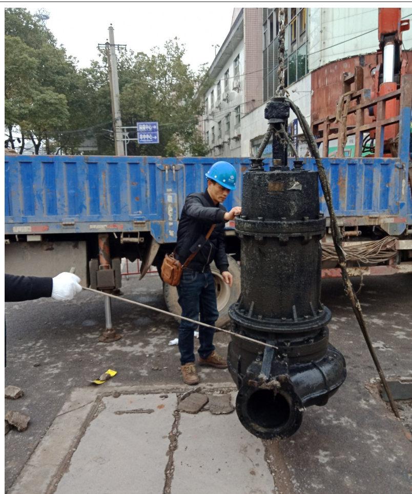
从3月初开始,桃源县漳江皖水利管委会组织人员,对辖区内排渍排涝机埠、穿堤建筑物和以往出现险情的堤段进行检查检修。图为3月13日,技术人员检修排渍机埠电机。 游先祥 摄
